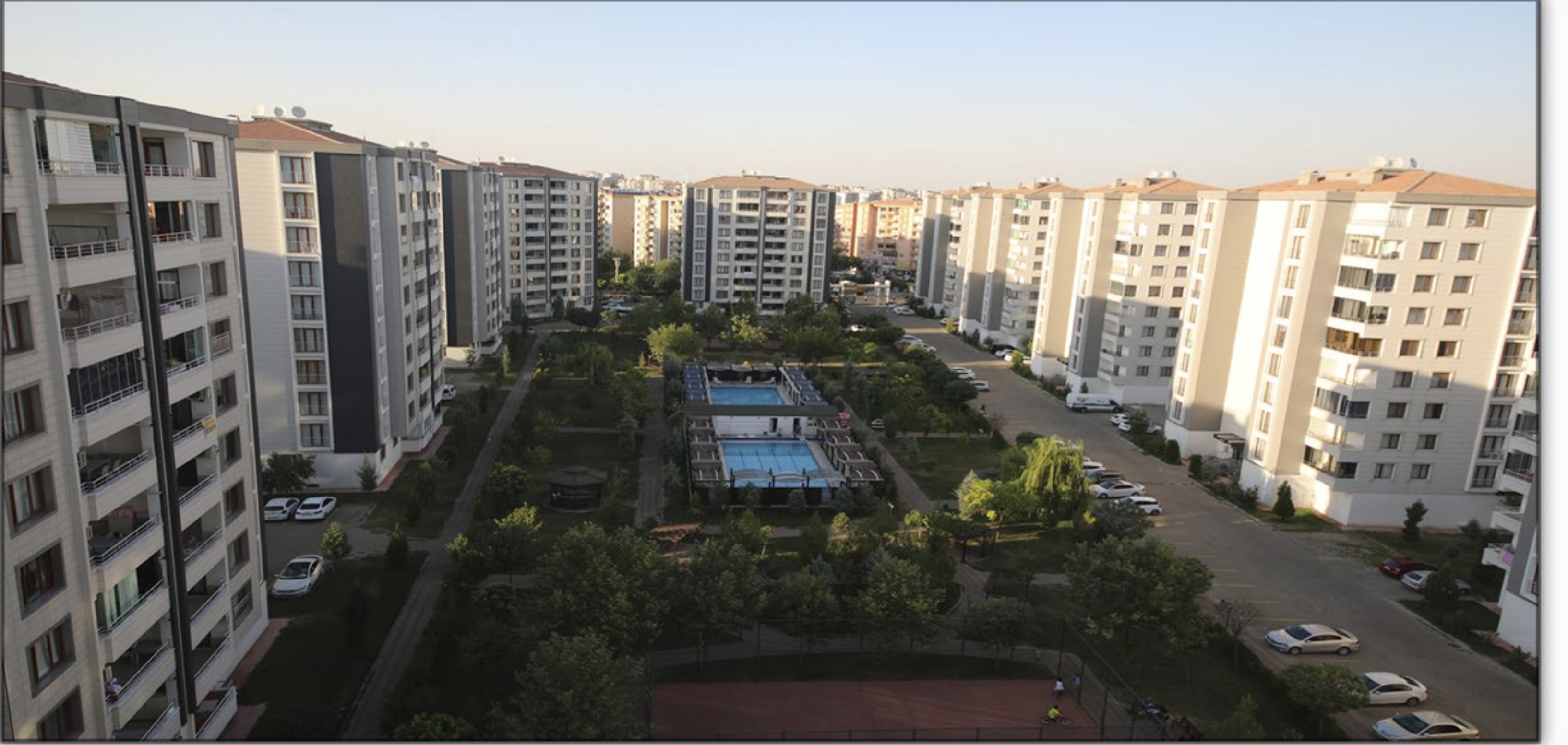
Diyarbakır / Türkiye Damla Alınak Sitesi 228 Daire Konut Uygulaması
